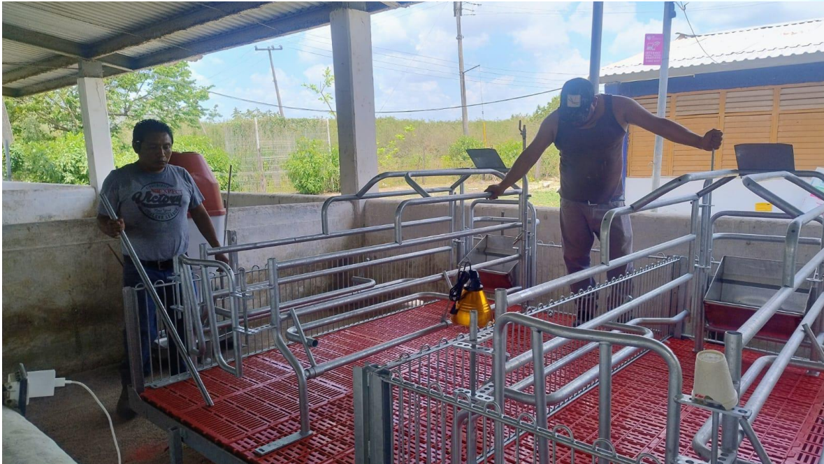
Imagen 20. Instalación de cama de maternidad doble. Fuente: Departamento de Mantenimiento de Equipo.
