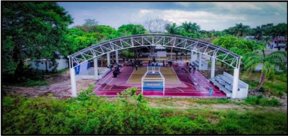
Imagen 47: "construcción de un Domo con Cancha Deportiva"
