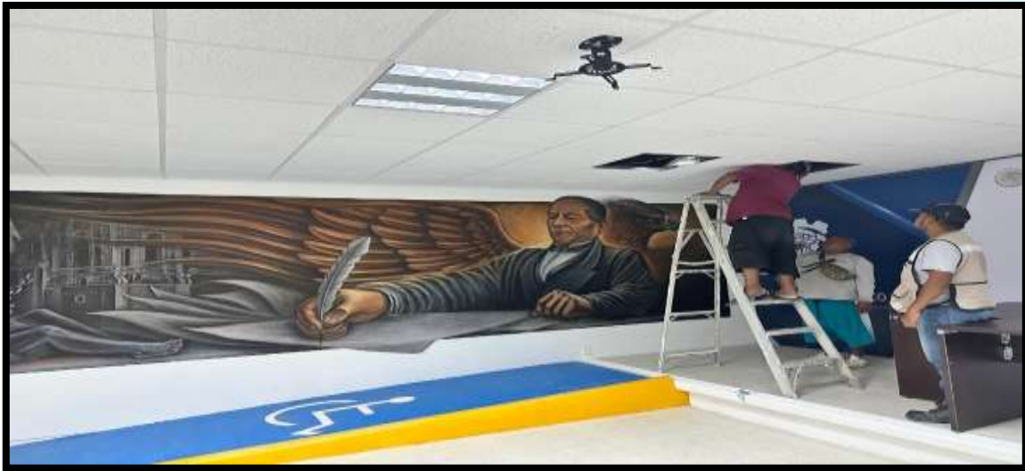
Imagen 39: "Rampa para la accesibilidad de las personas con discapacidad en la sala de titulación de ITZM"
