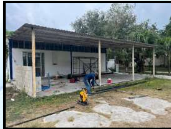
Imagen 41 "Adecuación de espacio para comedor comunitario"
